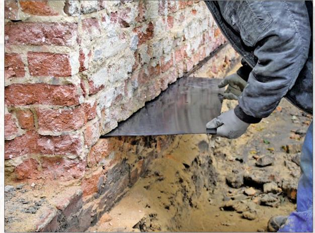
Anschließendes Verkeilen der Schnittfuge mit statisch belastbaren Kunststoffkeilplatten im Abstand von maximal 25 cm über den gesamten Mauerquerschnitt (Belastbarkeit mindestens 500 kp/cm<sup>2</sup>).
